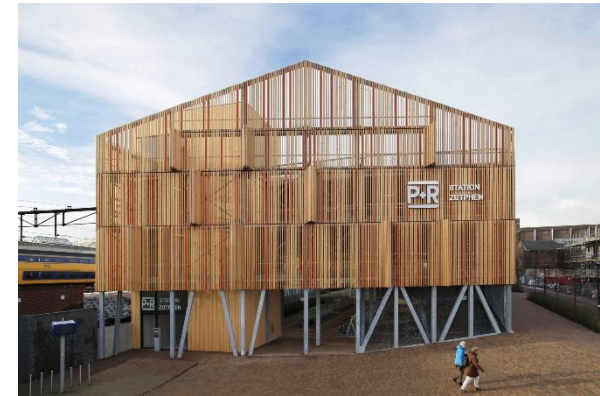
Beispiel: Fassade aus senkrechten Holzelementen P+R-Station in Zutphen Architekt: Moederscheim Moonen Architects aus Rotterdam Foto: Harry Noback, Bart van Hoek Quelle: https://herrmanns.wordpress.com/2017/04/20/p-r/
