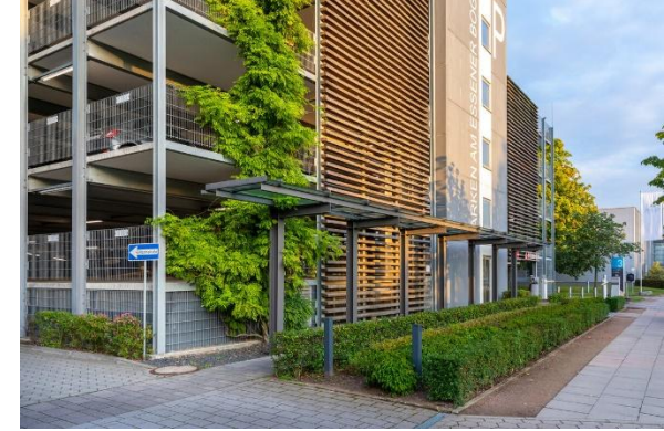
Beispiel: Holzelemente und Begrünung an der Außenfassade eines Parkhauses Quelle: https://www.umweltwirtschaft.nrw.de/green-practice-nrw/unternehmen/nachhaltiger-gewerbebau-als-prinzip-goldbeck/ Hersteller: Goldbeck, siehe auch unter: https://www.goldbeck.de/produkte-services/neubau/parkhaeuser/nachhaltige-parkhaeuser
